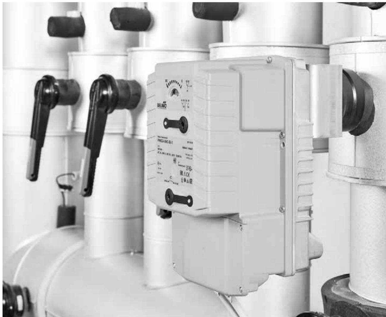
Applications tout-ou-rien et de dérivation polyvalentes grâce aux vannes papillon avec oreilles de centrage ou oreilles taraudées. Les vannes peuvent être installées sans restriction, indépendamment du sens du débit. Une étanchéité absolue (taux de fuite A, étanche) et des pressions de fermeture pouvant atteindre 14 bar sont d'autres avantages décisifs.
